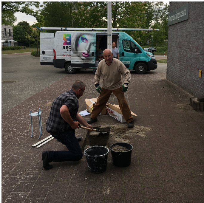
► Met vereende krachten wordt de derde vlaggenmast bij de kerk geplaatst.
